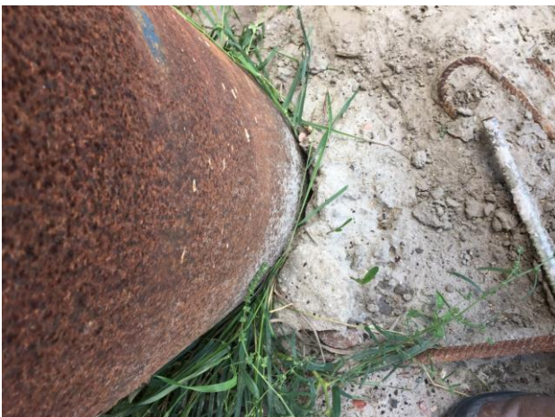
Figuur 2 - Speling bij het steunpunt (buispalen)
