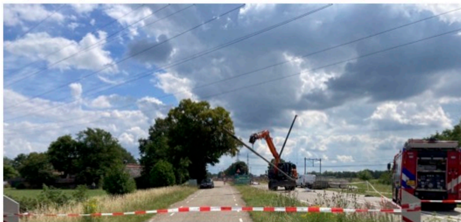
Foto van het incident. De giek van de kraan stond ten zijde van het ongeval hoger, waardoor de lichtmast in de risicozone van de hoogspanningslijnen kwam (≈ 3 meter bij 110kV).
