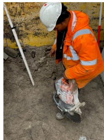
Afbeelding 2: medewerker verstapt zich bij het opstaan waarbij 1 hand van de hendel van de bandenzaag is geschoten en de bandenzaag naar beneden is geslingerd
