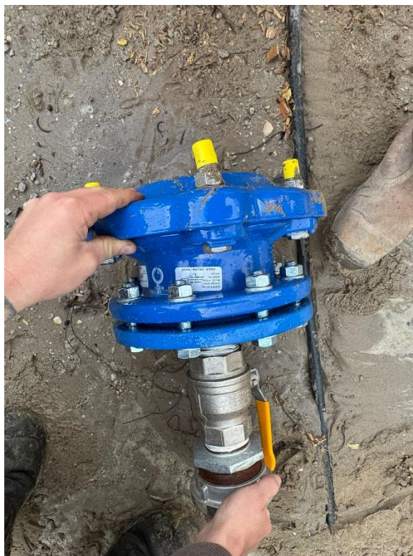
Figuur 3 - Weggeschoten gripflens
