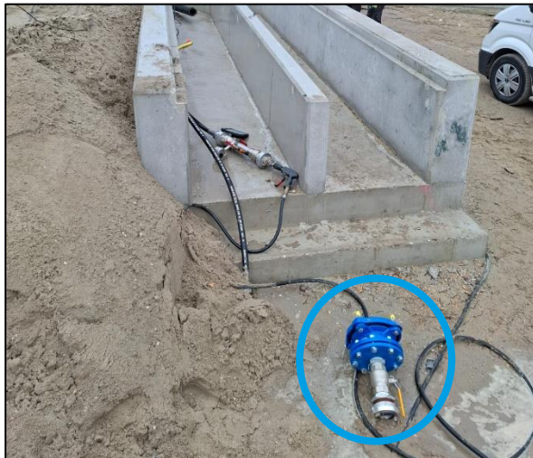
Figuur 1 - Gripflens inclusief afpersapparaat
