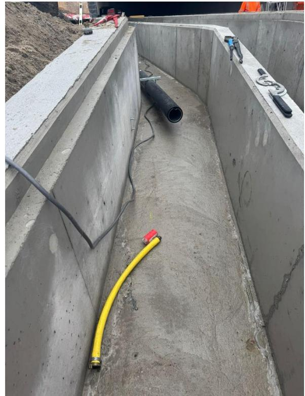
Abbildung 5 - Kabelkanal Trockenlöschleitung
