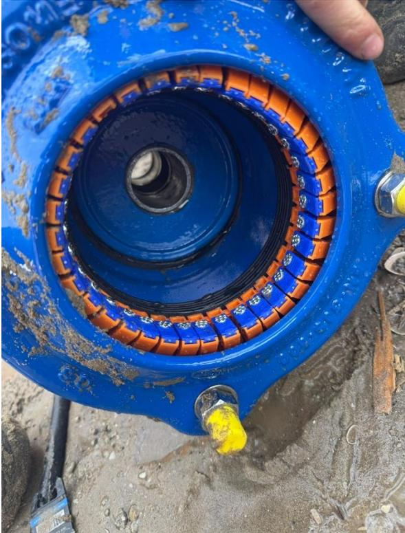
Abbildung 2 - Herausgeschleudertes Klemmflansch
