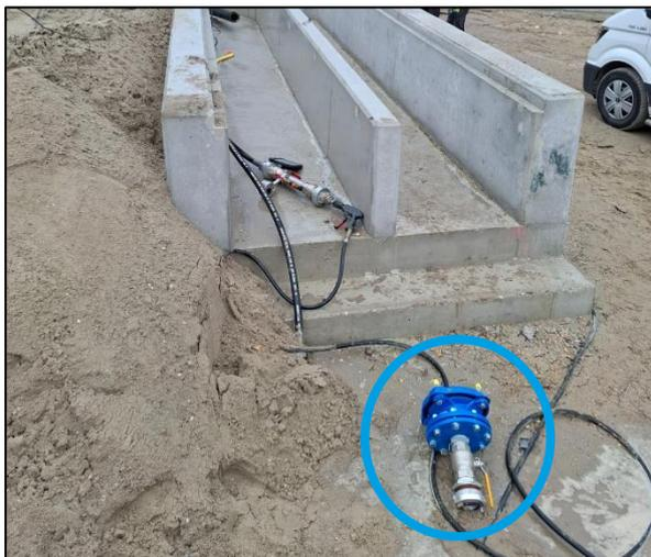
Abbildung 1 - Klemmflansch mit Abdrückvorrichtung
