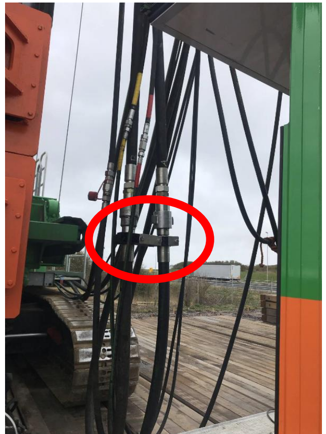
Nieuw aangebrachte afstandhouder
