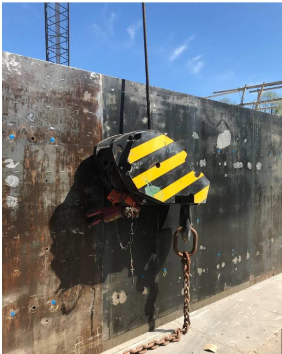
Foto 1: Tunnelbekisting met hijsblok
