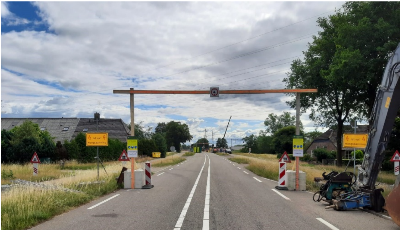
Aangebrachte portaal met daarbij aangegeven de maximale hoogte en het verplichte gebruik van een sleepketting. Er wordt een standaard portaaltype ontworpen voor plaatsing rondom hoogspanningsleidingen.
